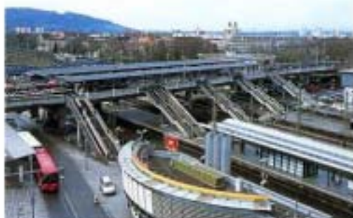
エスカレータ等で直結されたLRT停留所と鉄道駅ホーム
