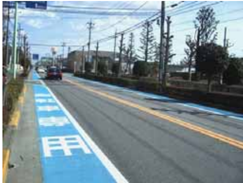
自転車専用通行帯（越戸通り）
