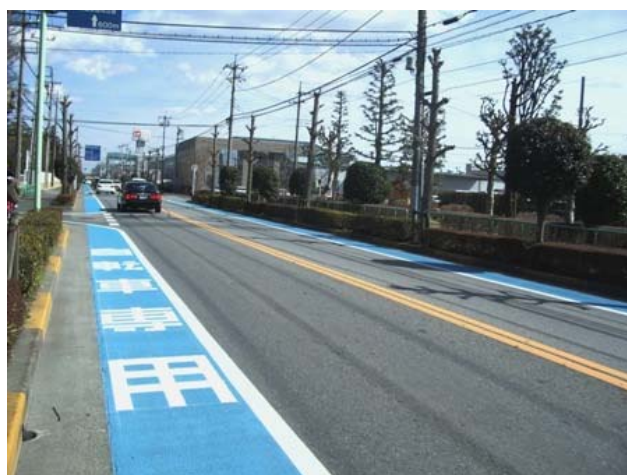
自転車専用通行帯 (青色のカラー舗装)
