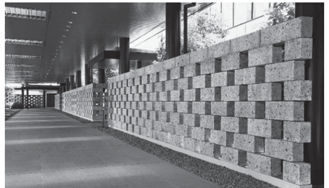
写真8 悠久の丘 「大谷石 未来へ」から
