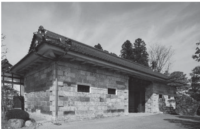
写真6 大塚家長屋門 「大谷石 未来へ」から
