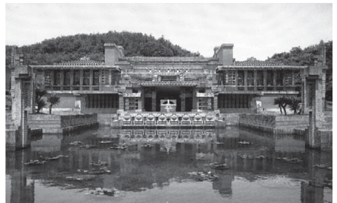
写真3 旧帝国ホテル・ライト館 「大谷石 未来へ」から
