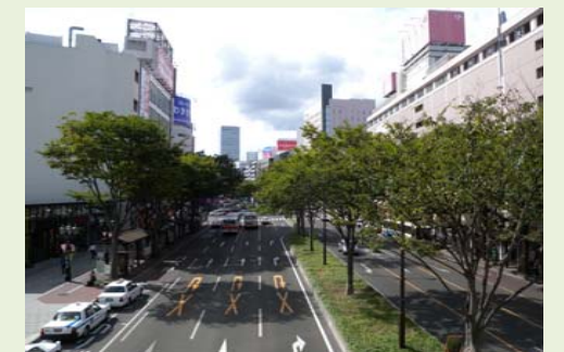
緑を生かした景観形成の例 (仙台市青葉通)
