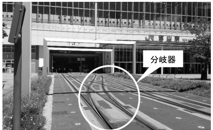
写真1 分岐器の設置事例（富山駅）
