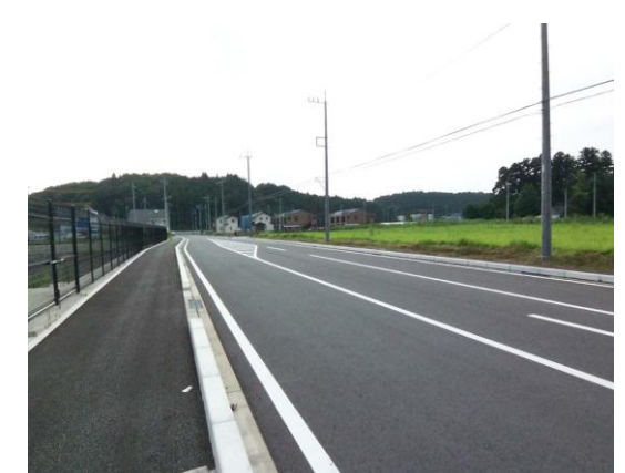
土地区画整理事業地内 ①区画道路整備
