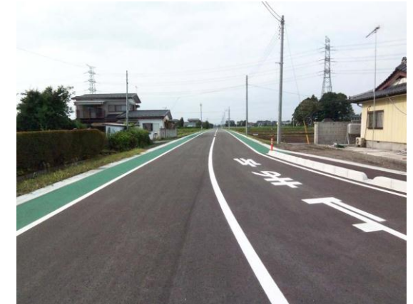
②道路（市道13125号線）
