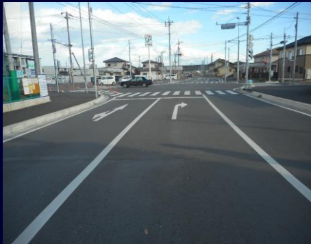
市道713号線 (既存道路の拡幅・歩道設置)
