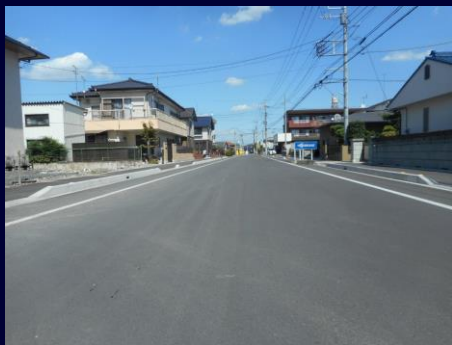
市道704号線 (既存道路の拡幅・歩道設置)
