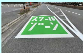
道路 路面標示(スクールゾーン)
