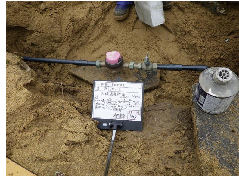
修繕後の状況
