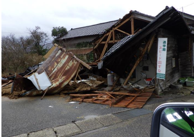
倒壊した家屋
