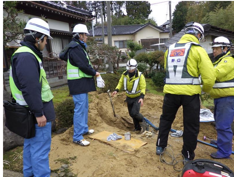
修繕作業の様子
