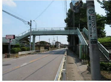
写真：姿川第一小学校前歩道橋
