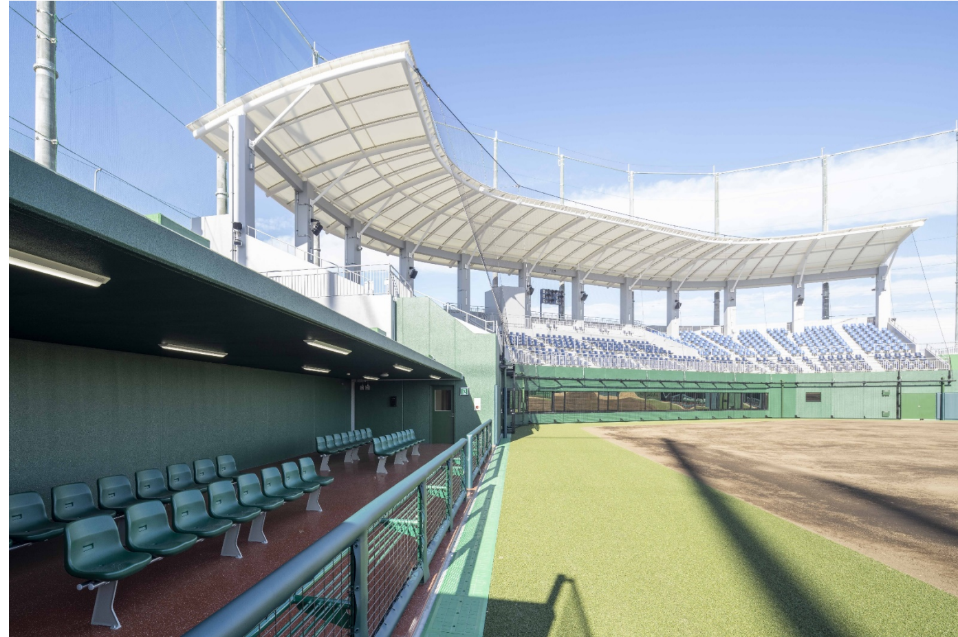
▲改築した宮原運動公園野球場
