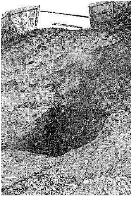
図 6-6 廃石綿等の埋立用穴
