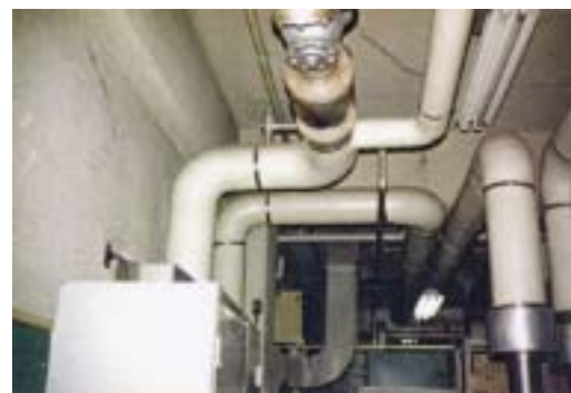
吸音・断熱(機械室、壁・天井)
