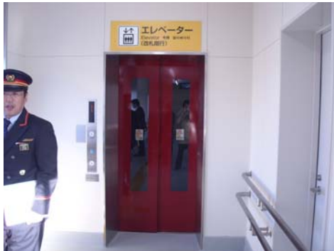
＜新設置のエレベーター＞
