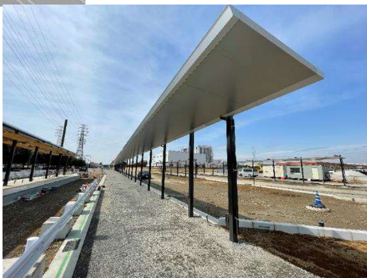
トランジットセンターの整備状況 (清原工業団地)
