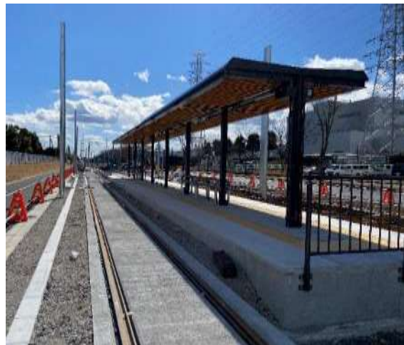
軌道・停留場の整備 (清原工業団地)
