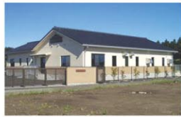
▲農業集落排水処理施設
