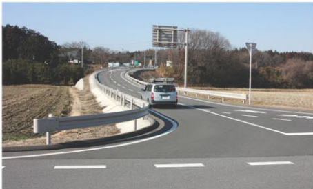
▲上河内スマートインターチェンジへの取り付け道路
