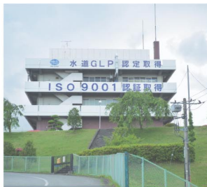
▲松田新田浄水場
