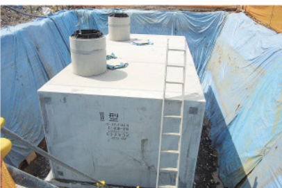
▲整備が進む防火水槽
