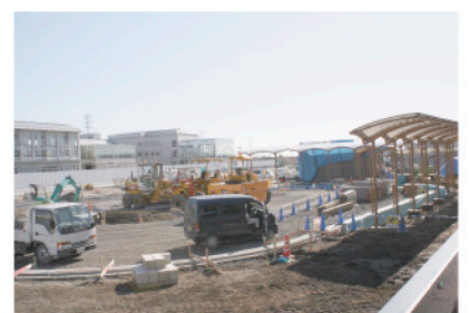
▲整備が進むJR雀宮駅東口
