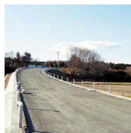
▲上り線の接続道路
