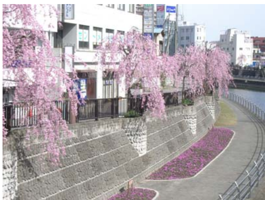
写真7 田川沿いのシダレザクラ（現状）
