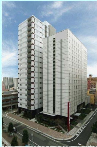
施設全景北東側より
