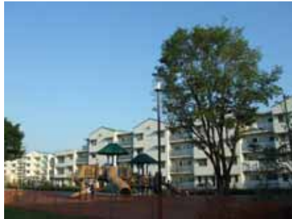
4階建ての中層集合住宅（山王市営住宅）
