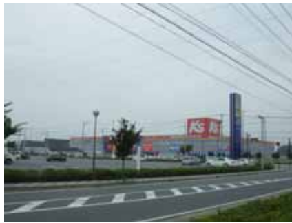
大型の屋上広告や広告板が掲出される大規模物販店 (宇都宮インターパーク)
