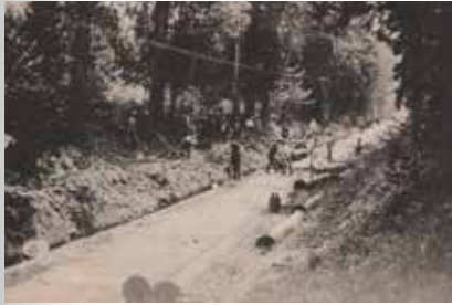
◀日光街道の送水管敷設 今市の浄水構場から国本村大字戸祭(現・中戸祭)の配水構場(約27キロメートル)に送水するため、日光杉並木でも敷設工事が行われました。
