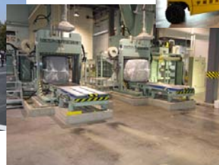
圧縮梱包されて搬出されるプラスチック製容器包装
