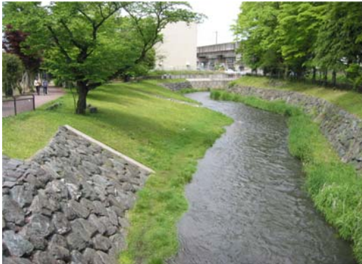
一級河川御用川 錦中央公園付近 河畔林の保全を行った
