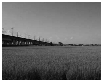
<新幹線の高架橋と田園風景>
