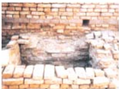
(写真:2) もヘンジョ・ダロの家々から流された下水をこの「マス」に受け入れ、地中にしみこませていました。
