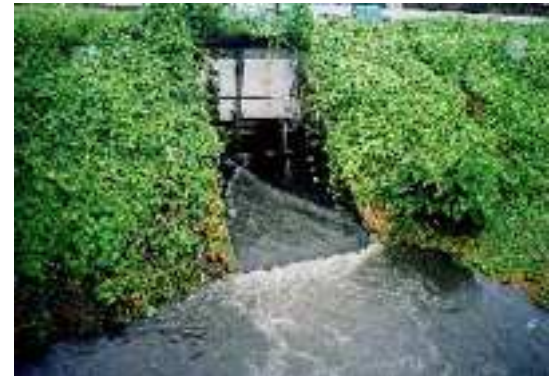
大雨時における雨水吐口からの越流水
