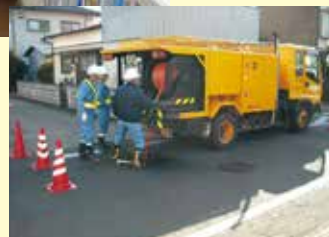
▶下水道管の 清掃作業
