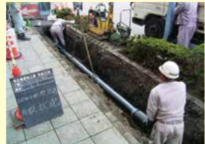
▲古くなった水道管の交換
