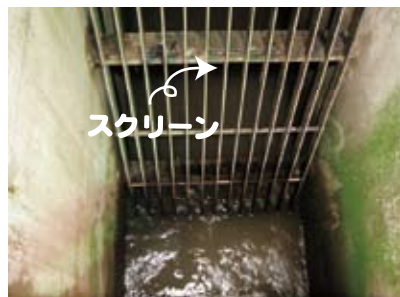
▲スクリーン・沈砂池 地下の池で砂やゴミを取り除きます。
