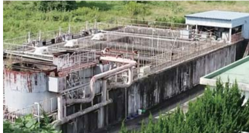
▲グリーンタウン地域下水処理施設
