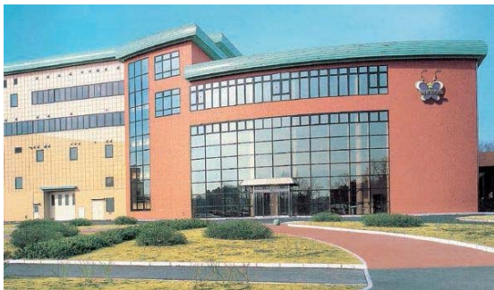
クリーンパーク茂原 リサイクルプラザ
