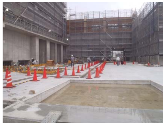
プラットホームエリア(ごみ焼却棟)
