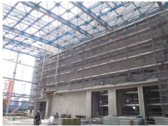
プラットホームエリア(ごみ焼却棟)
