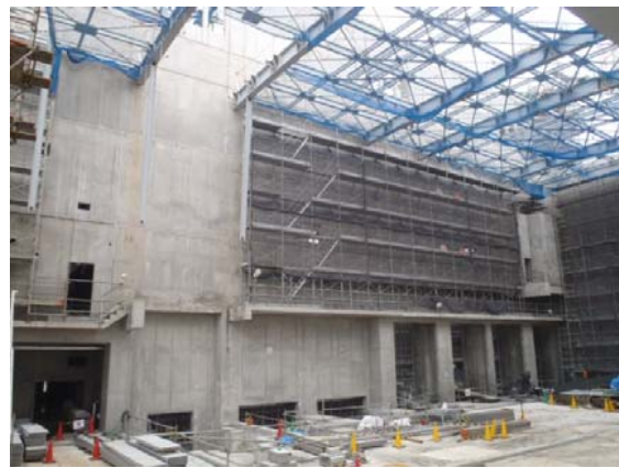
プラットホームエリア(ごみ焼却棟)
