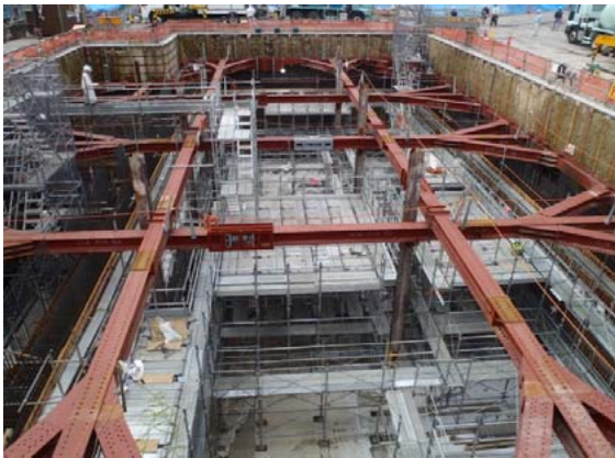
ごみピット(ごみ焼却棟)
