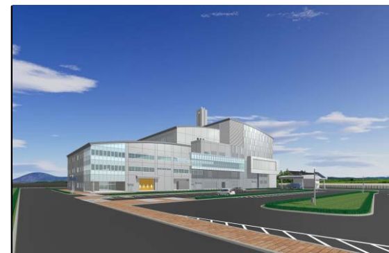
完成イメージ(南西からの見上げ)
