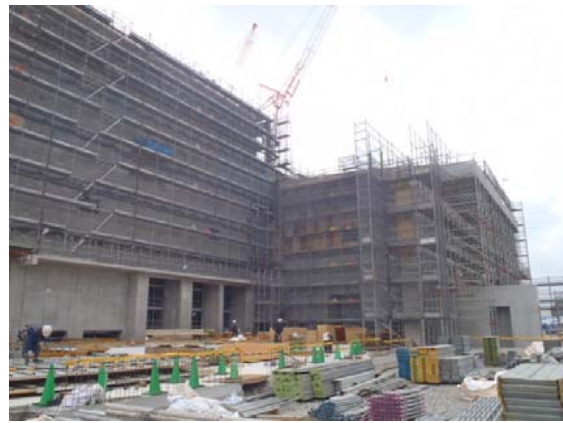
プラットホームエリア(ごみ焼却棟)
