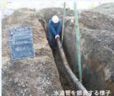
水道管を撤去する様子
