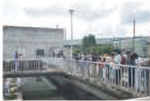
川田水再生センター
