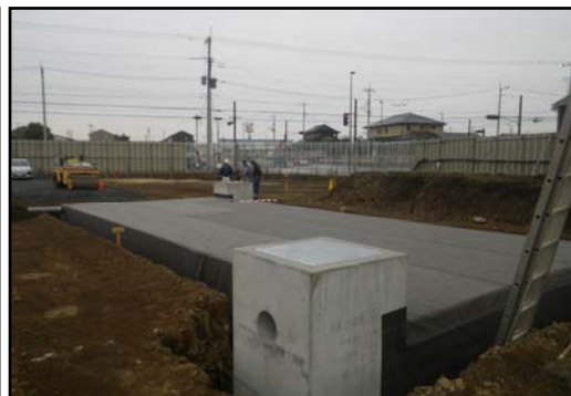
雨水浸透槽の設置
