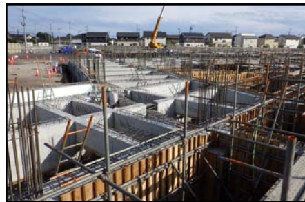
校舎基礎工事
