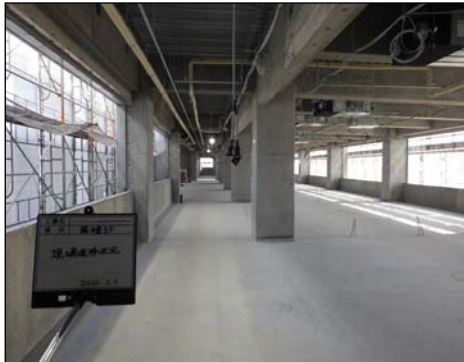
校舎内部（令和2年3月上旬撮影）
