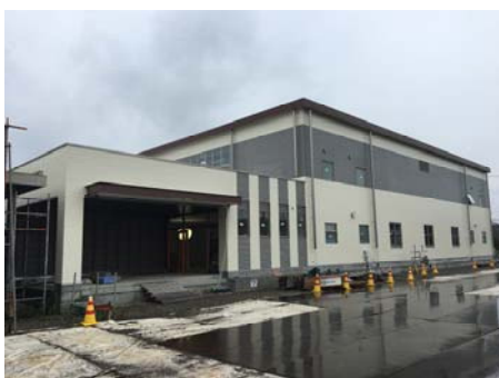
体育館写真（令和2年7月下旬撮影）
