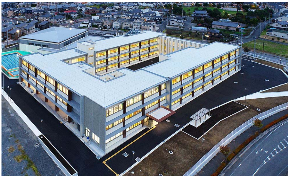
南西から撮影した校舎
