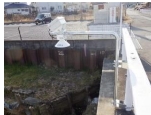
河川監視カメラ
