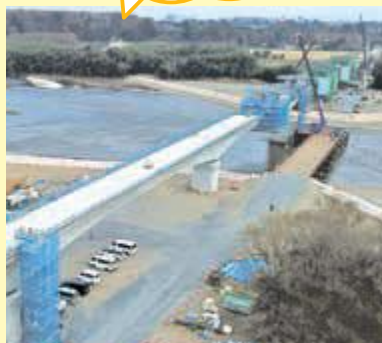
▲現在の鬼怒川橋りょう工事の様子。
