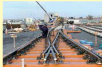
▲車両基地内のレール工事の様子。
