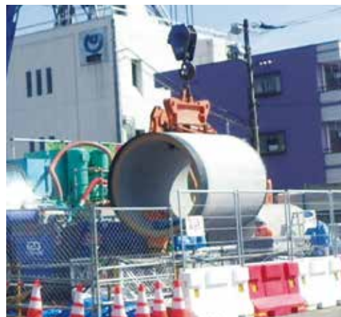
雨水幹線の整備
