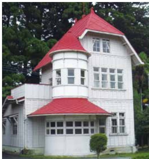
今市浄水場旧管理事務所
