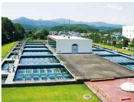
松田新田浄水場
