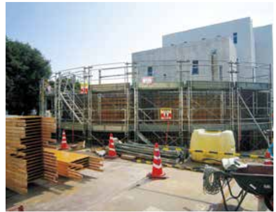
川田水再生センター設備更新工事
