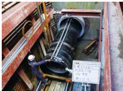
導水管の耐震化工事
