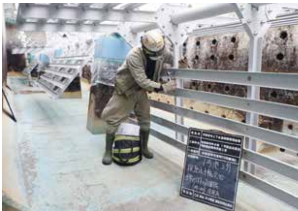
松田新田浄水場の設備更新工事
