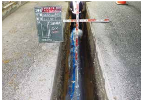
老朽配水管の布設替工事
