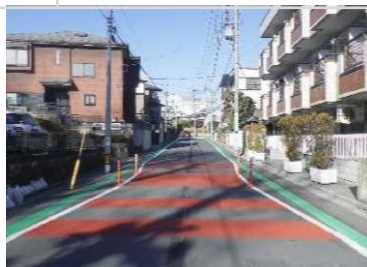
ゾーン30プラスによる路面の カラー塗装などの交通安全対策 (事例: さいたま市浦和区 前地地区ほか)
